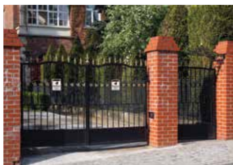
Entrées à serrures électroniques
